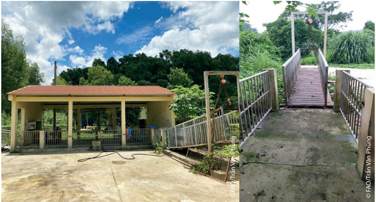
Hình 33. Nhà và cầu xuất bán lợn
